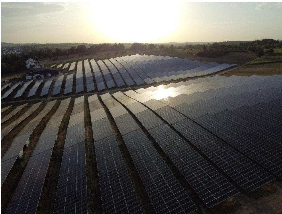
Solarpark Pfaffenklinge Weissach im Tal mit 11,6 MWp. Inbetriebnahme Juli 2026. Foto: Jochen Kögel, August 2026
