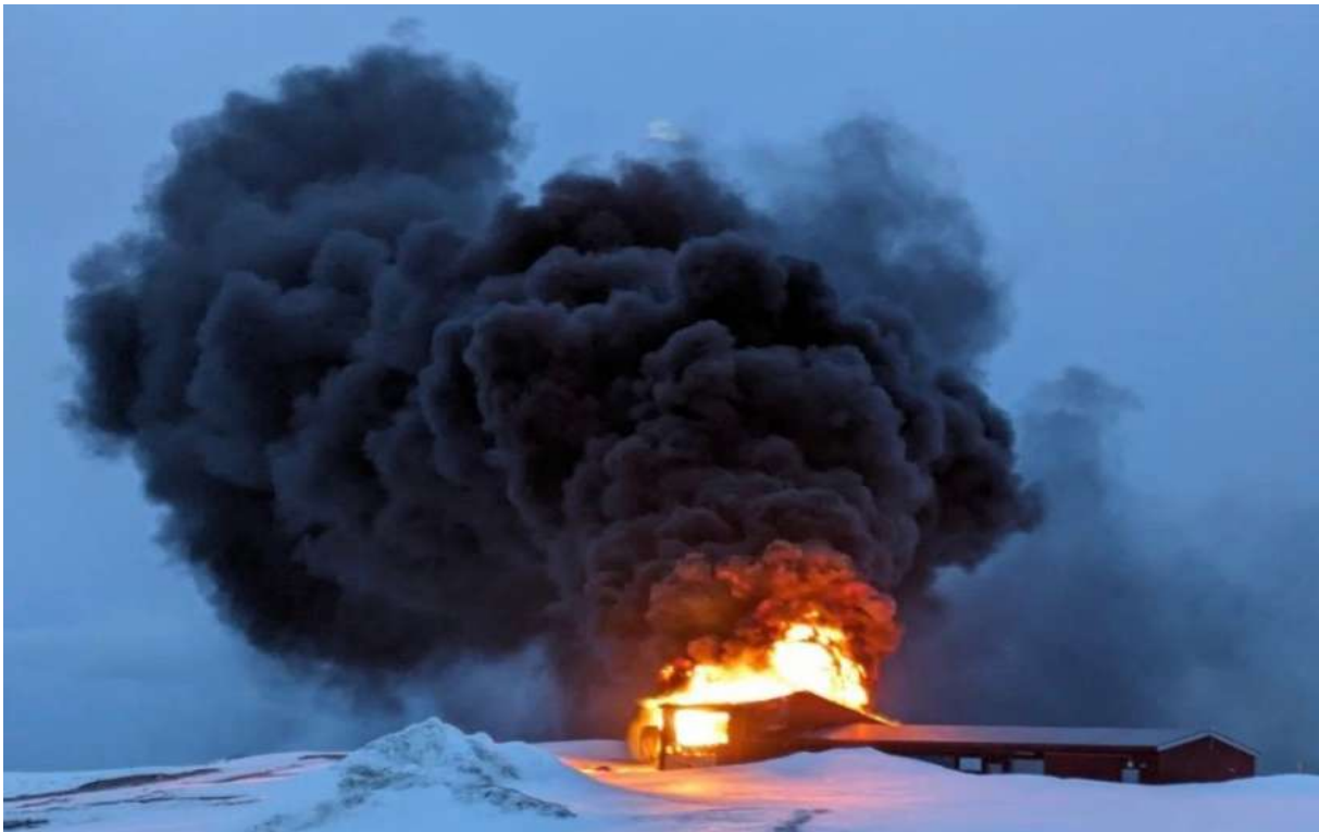
Havøygavlen trafobrann 30. januar 2024.
